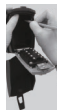
À l'aide du crayon, marquez la position des trous à percer pour les vis.
